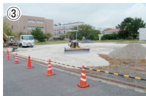
③ 駐車場整備のための 路盤材としての再利用
